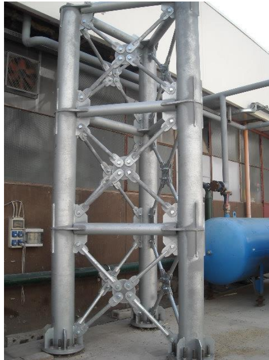
Strutture in elevazione
