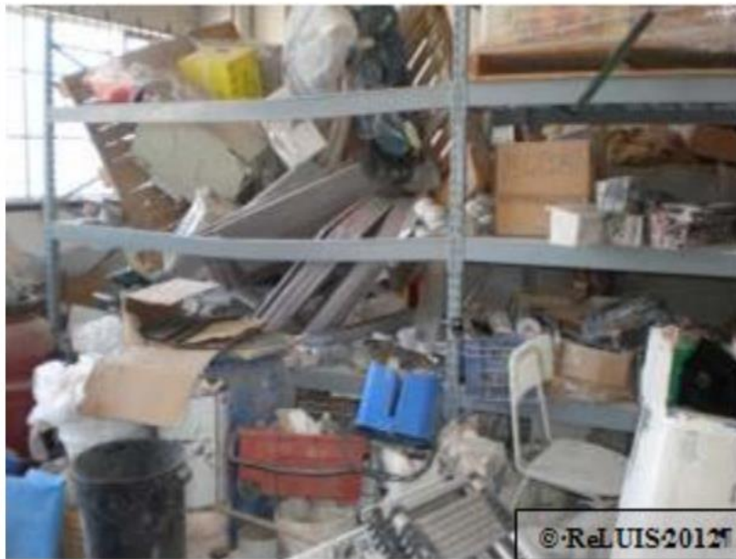
Danneggiamento scaffalatura con conseguente perdita del materiale contenuto
