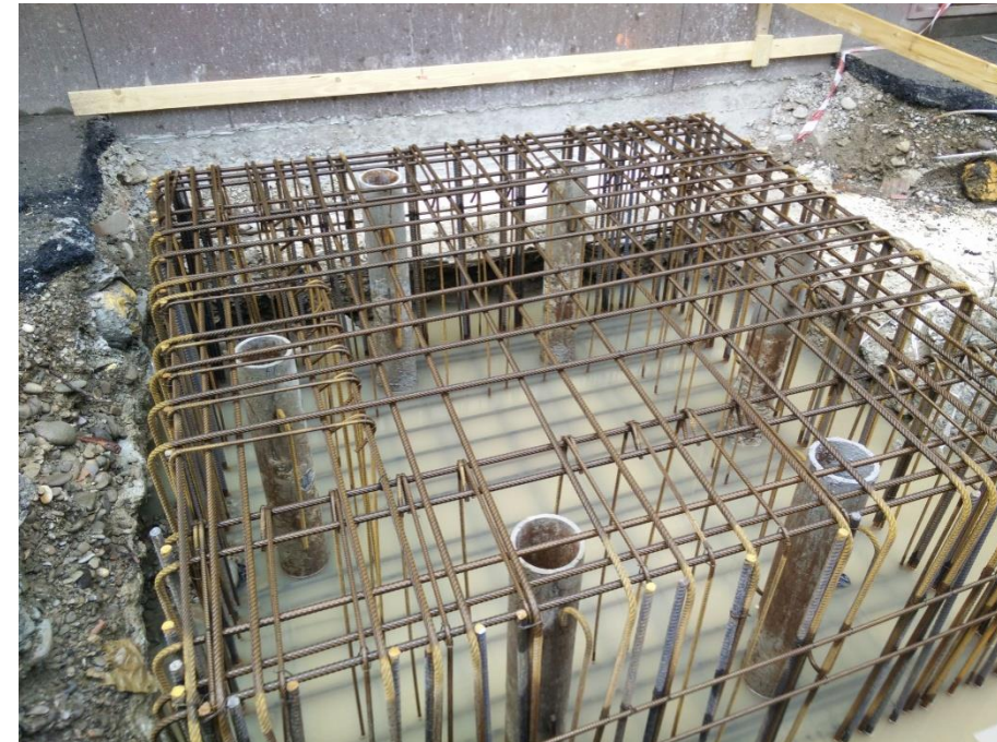
Strutture di fondazione
