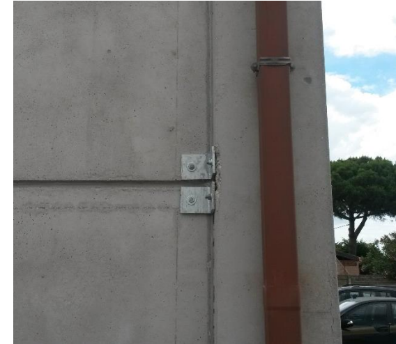
Collegamento pilastro-pannello
