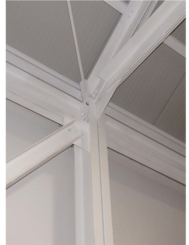
Nodo di collegamento
