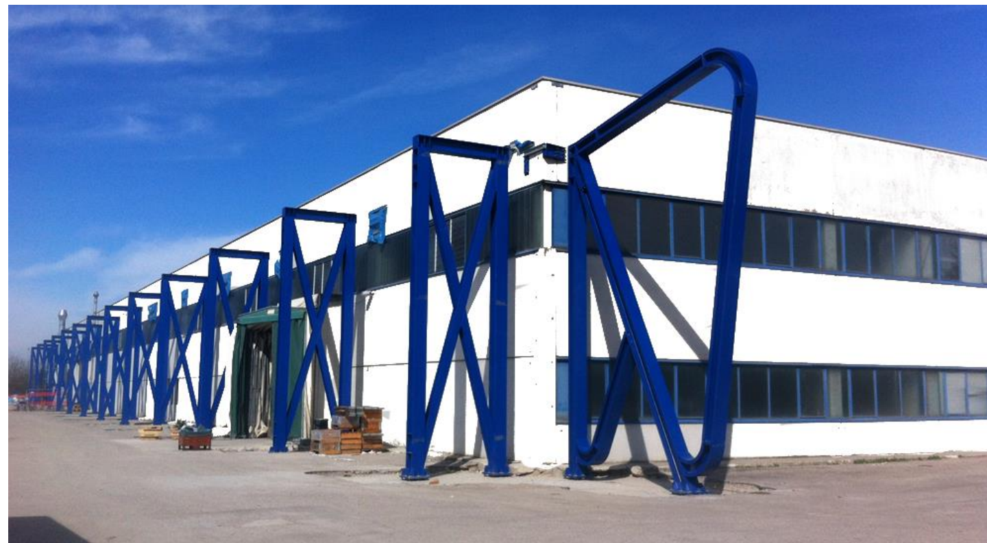
Realizzazione ultima del miglioramento sismico
