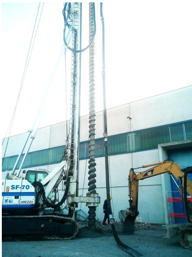
Trivellazione pali
