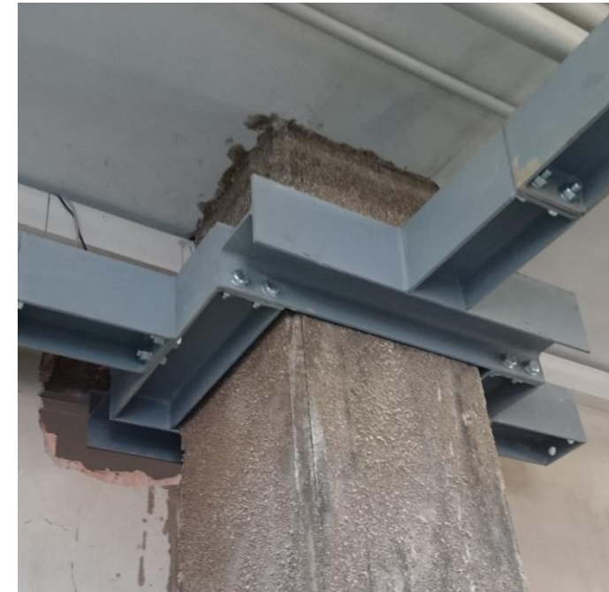
Collegamenti pilastri con setti esterni
