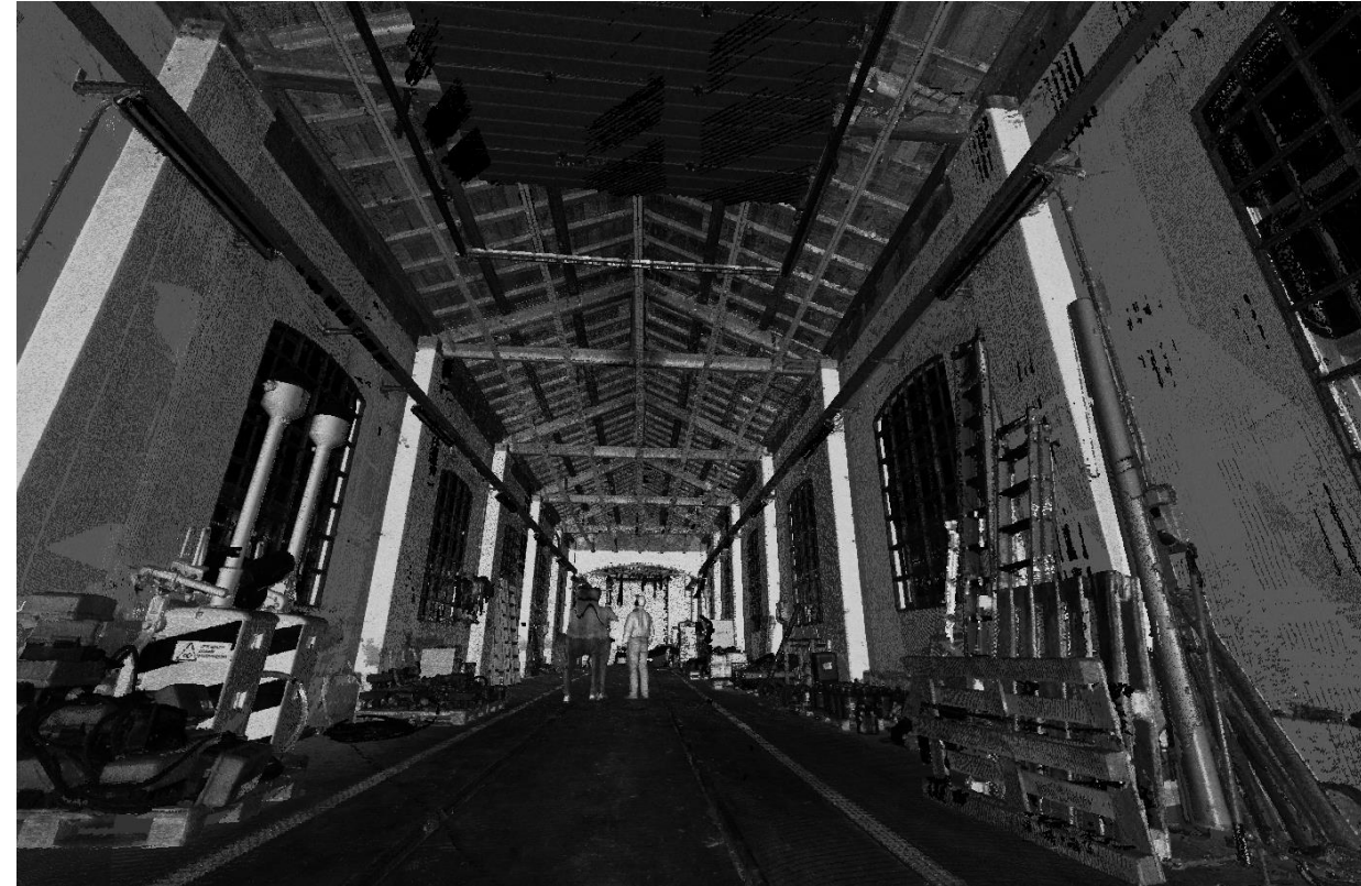
Interno acquisizione interferenze impianti
