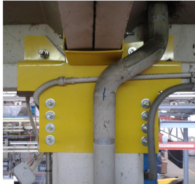
Collegamento pilastro-trave-tegolo
