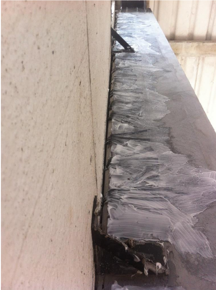
Applicazione resina strutturale
