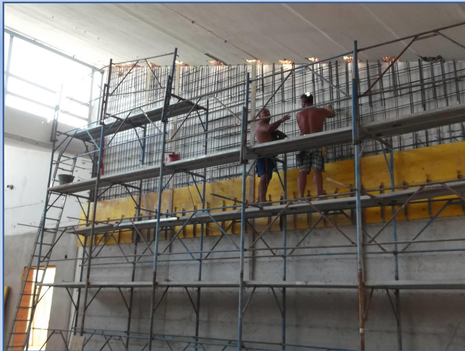
20 agosto 2012: l'esecuzione delle pareti controventanti
