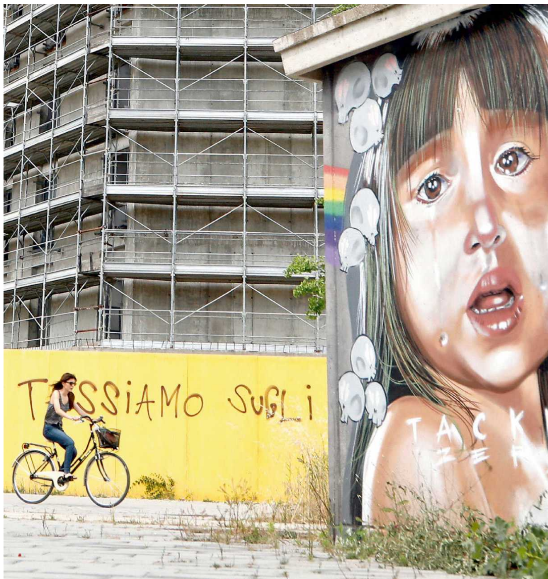
➤ Un cantiere edile in città
