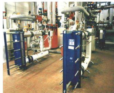
Sottocentrale Teleriscaldamento
